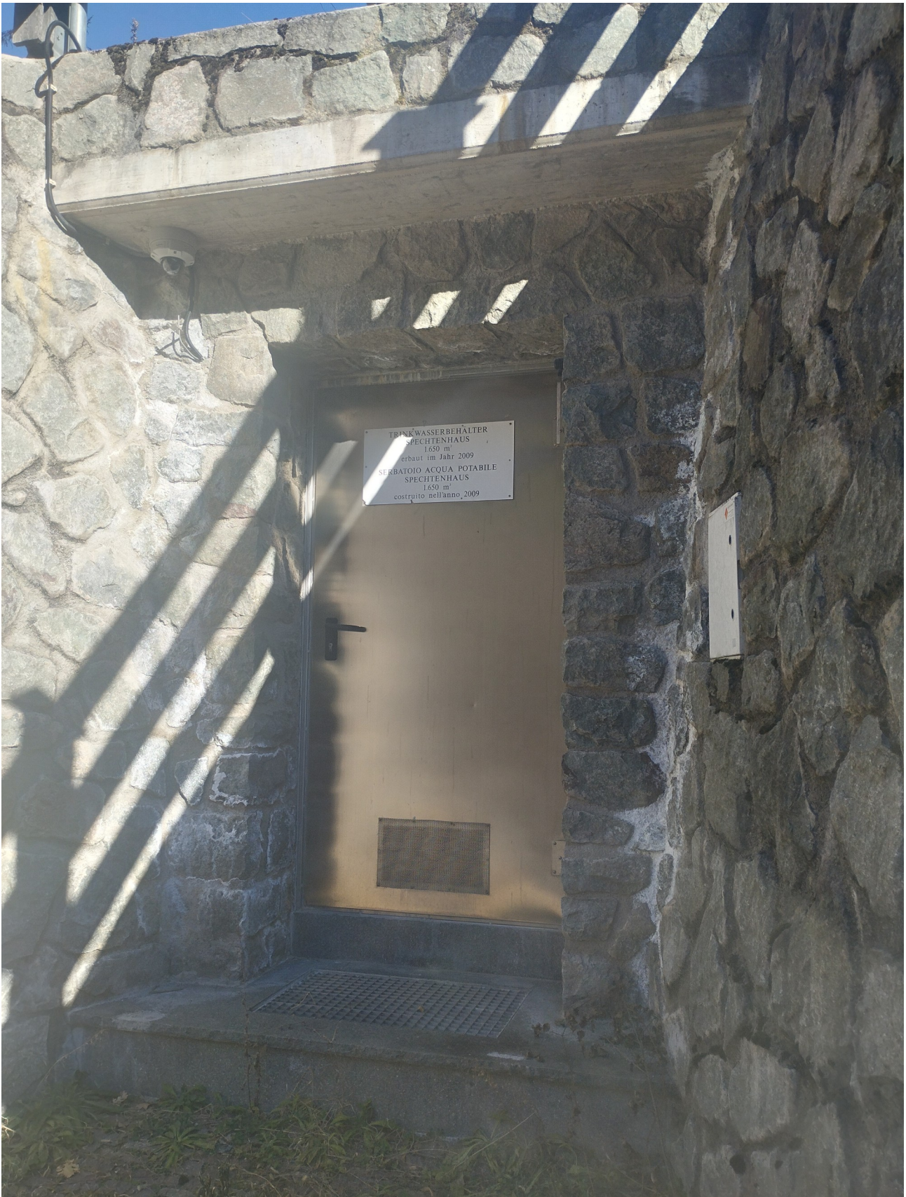
Abb.5 Tür mit Überwachungskamera Trinkwasserbehälter „Spechtenhaus“ Immagine 5 Porta con telecamera di sorveglianza serbatoio acqua potabile „Spechtenhaus“
