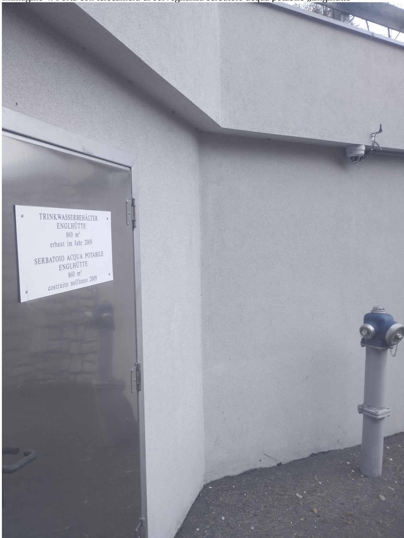
Immagine 4: Porta con telecamera di sorveglianza serbatoio acqua potabile „Englhütte“
