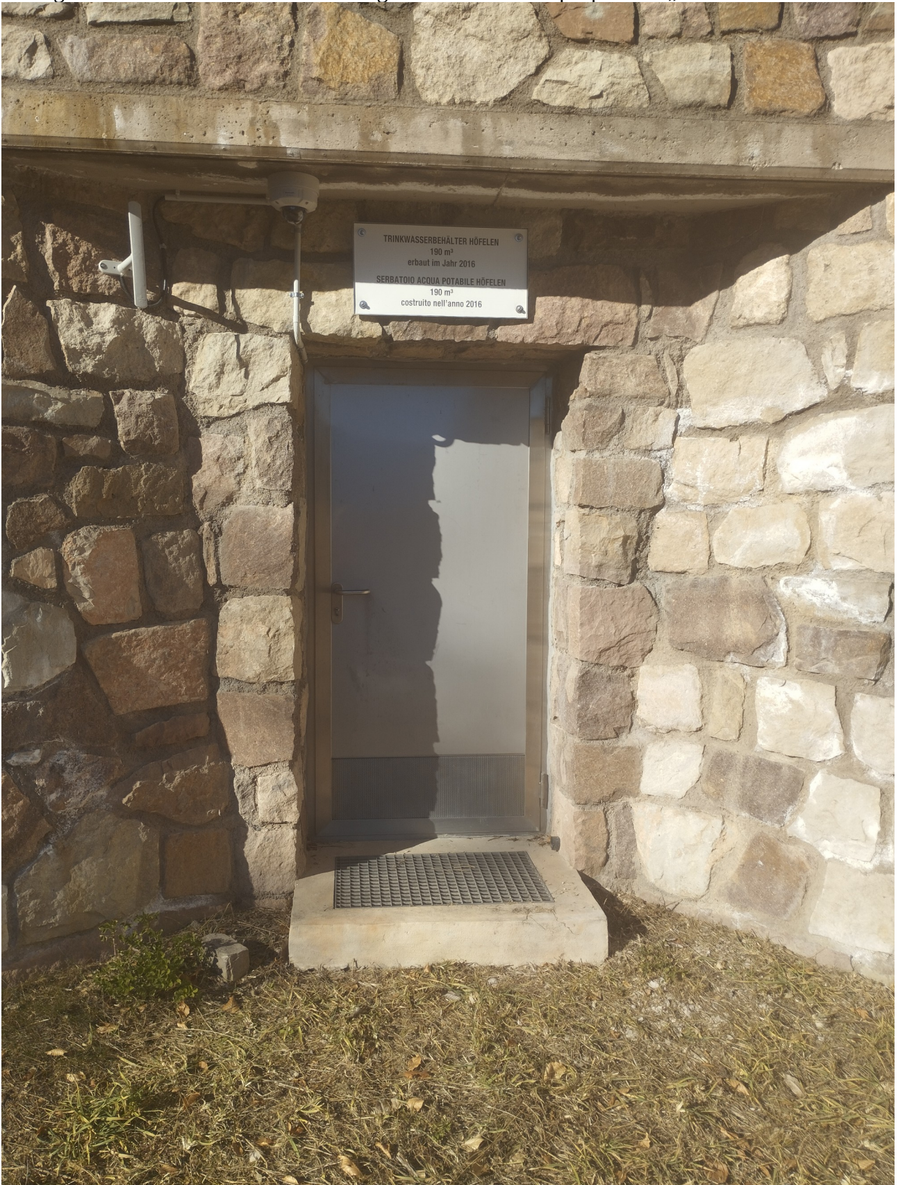
Abb.2 Tür mit Überwachungskamera Trinkwasserbehälter „Höfelen“ Immagine 2 Porta con telecamera di sorveglianza serbatoio acqua potabile „Höfelen“
